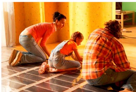
Еще одна особенность этого решения — параллельное включение в электрическую цепь карбоновых нагревательных элементов. Благодаря такой конструкции пленку можно нарезать кусками нужного размера, что делает монтаж практически безотходным.
