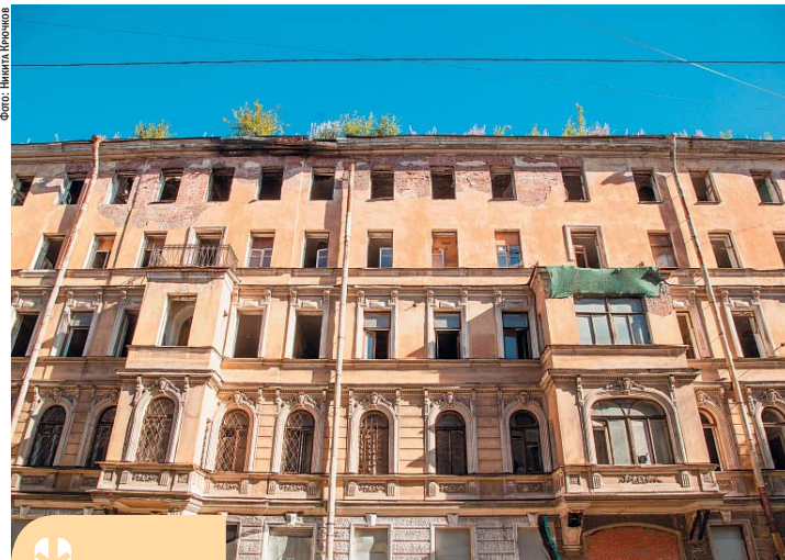
Полуразрушенный доходный дом Крутикова на 11-й Красноармейской ул., 7, после реставрации заселят участники программы «Молодежи – доступное жилье»
