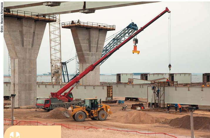
Строительство центрального участка диаметра считается наиболее сложным
