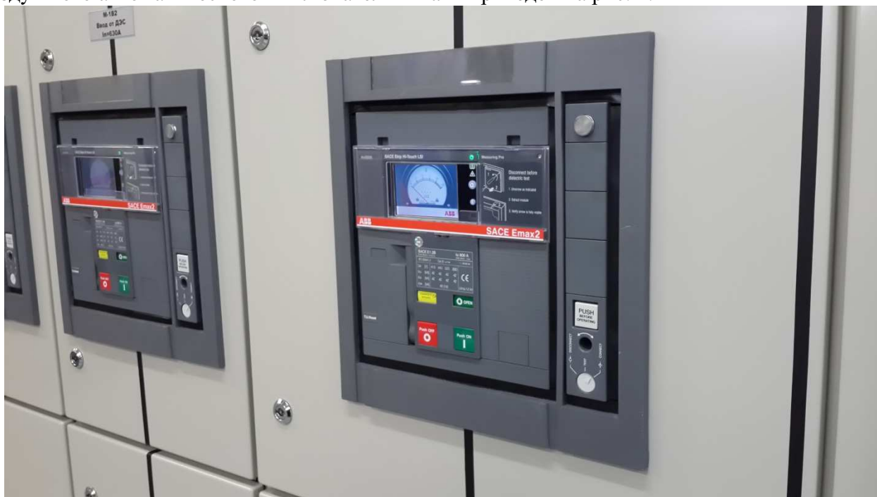
Рис. 1. Воздушные автоматические выключатели серии Emax2 в ЩСН.
