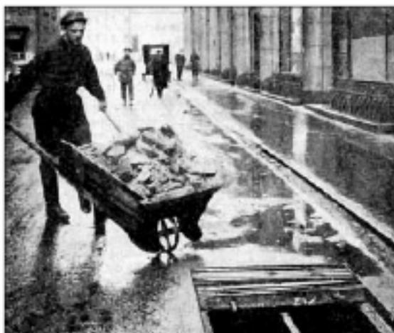
Рис. 1. Паровая снегоплавильная установка на улице Ильинка в Москве (люк для загрузки снега)
